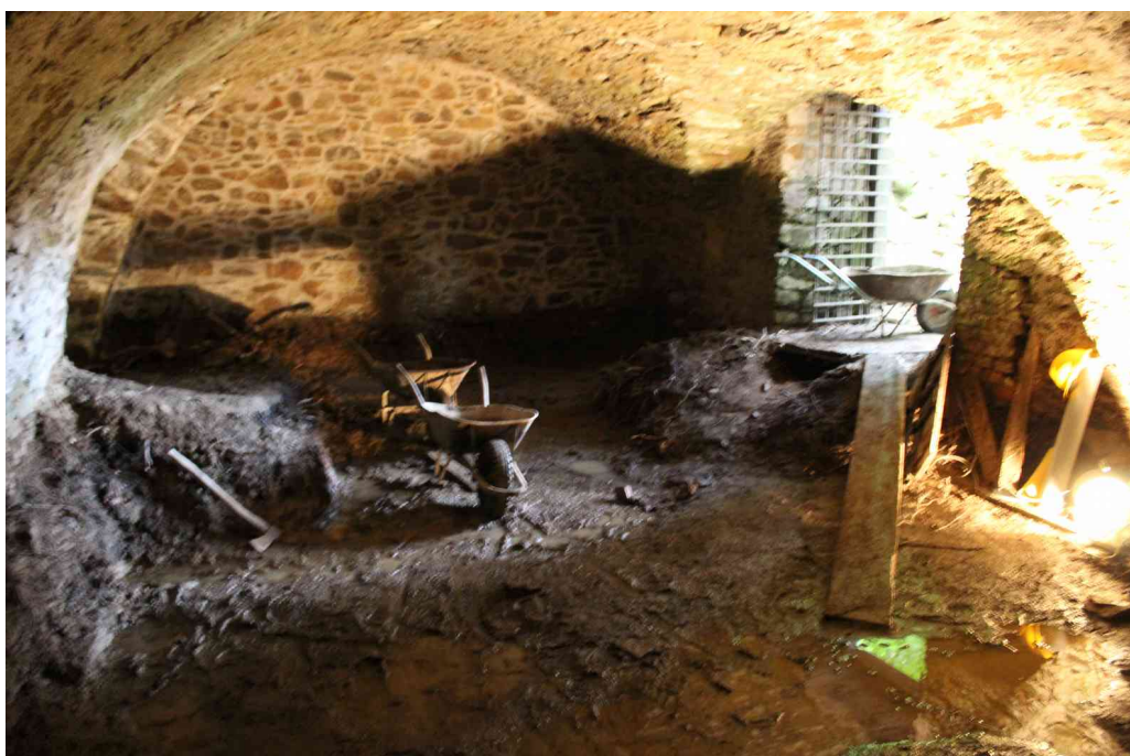
Provádění výkopů podlahy sklepa
